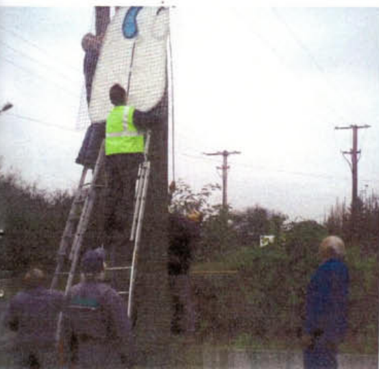
Mise en place des illuminations
