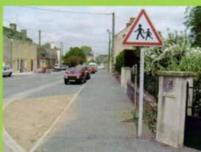
Hauteur sous panneau insuffisante
