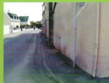
rétrécissement de trottoir
